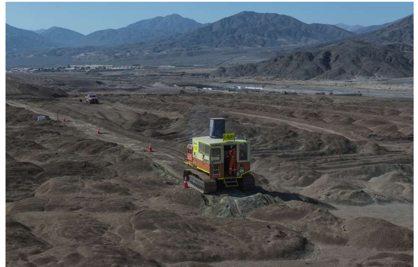
Figura 11: Maquinaria Fugro Sondaje CPT-FRX
